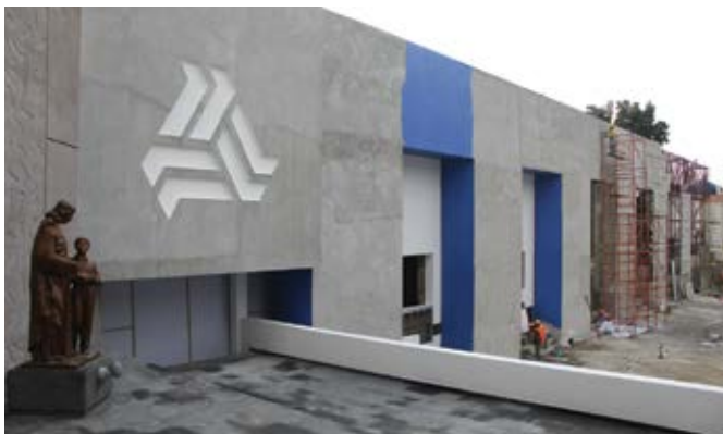
Fachada en proceso
